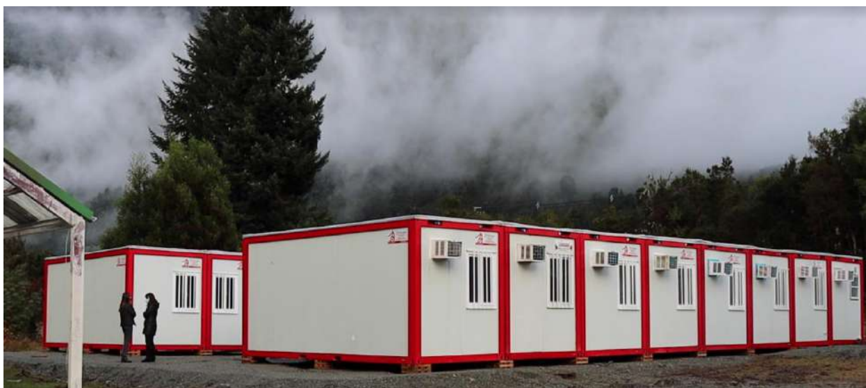
Instalación Escuela Modular Cristo Rey - junio 2021
